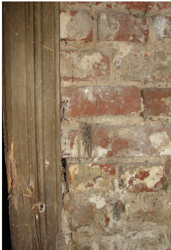
fot. 2 Ubytki zaprawy cementowej w pobliżu otworu drzwiowego.
