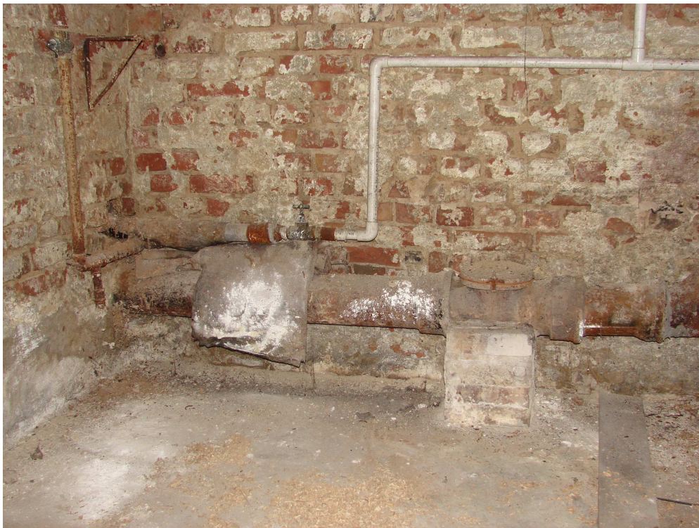
fot. 1 Złuszczone tynki ścienne w piwnicy.
