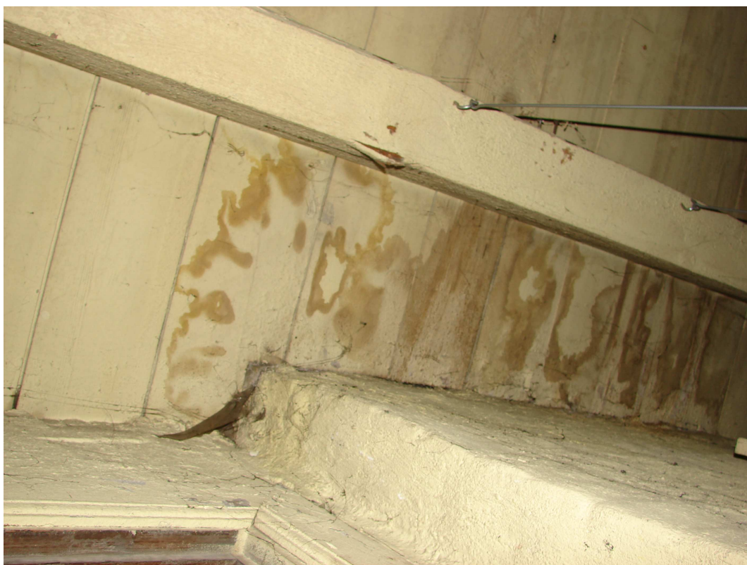
fot. 11 Zawilgocenia poszycia dachu.
