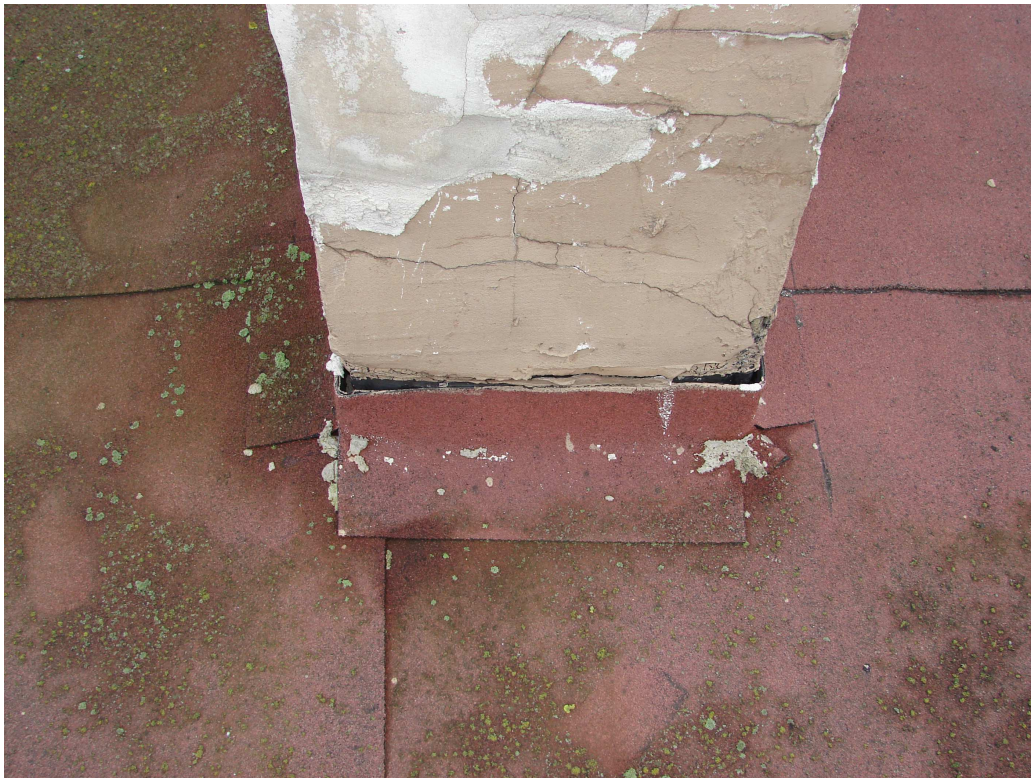
fot. 13 Błędy wykonawcze pokrycia dachu.
