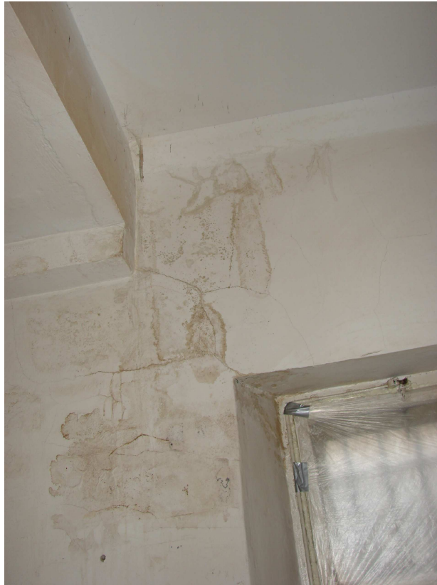
fot. 4 Przebarwienia w ścianie zewnętrznej nośnej.
