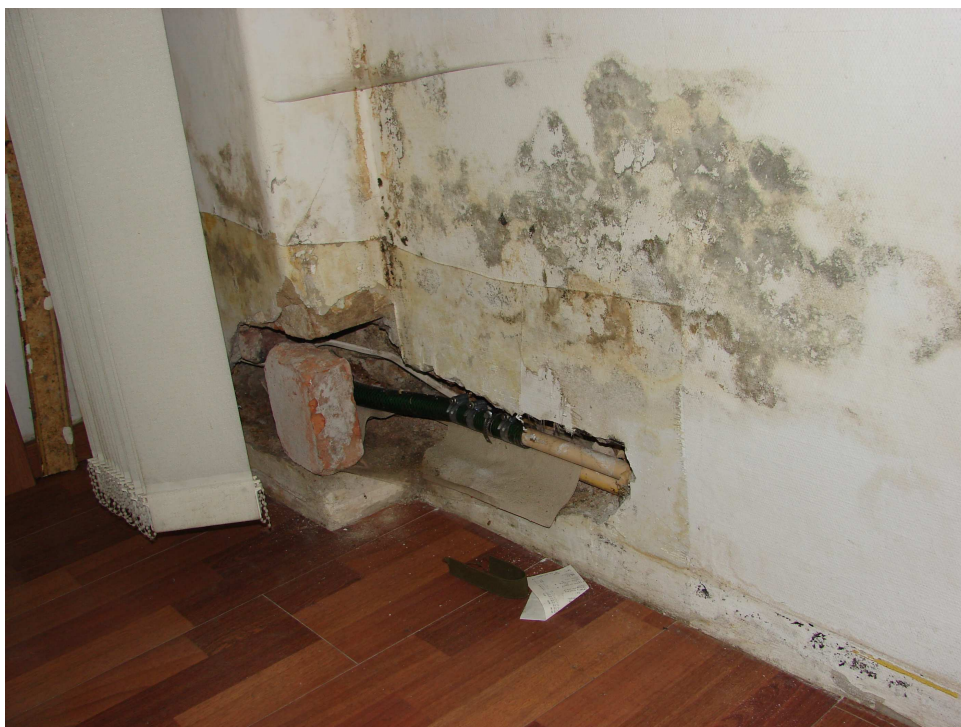
fot. 6 Zawilgocenie ściany na I piętrze w wyniku awarii instalacji centralnego ogrzewania.
