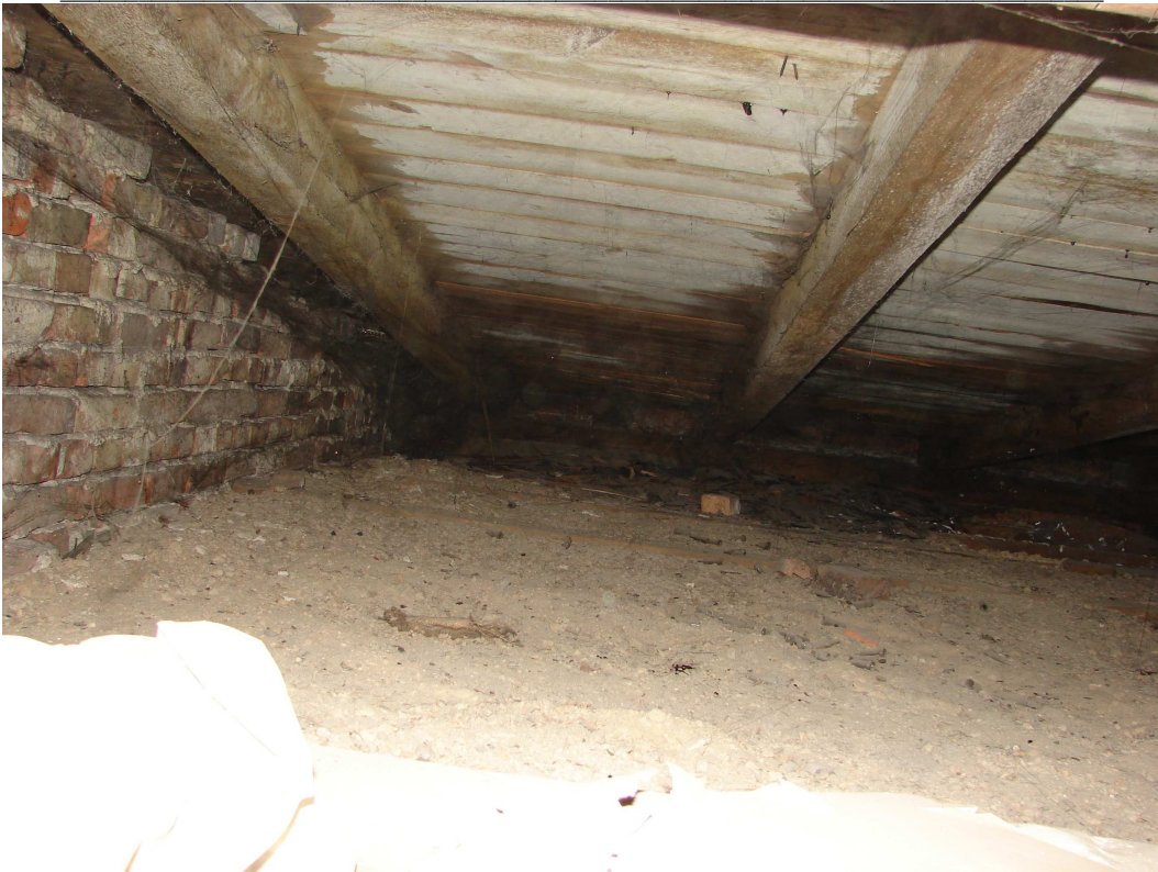
fot. 9 Zawilgocenia poszycia dachu.
