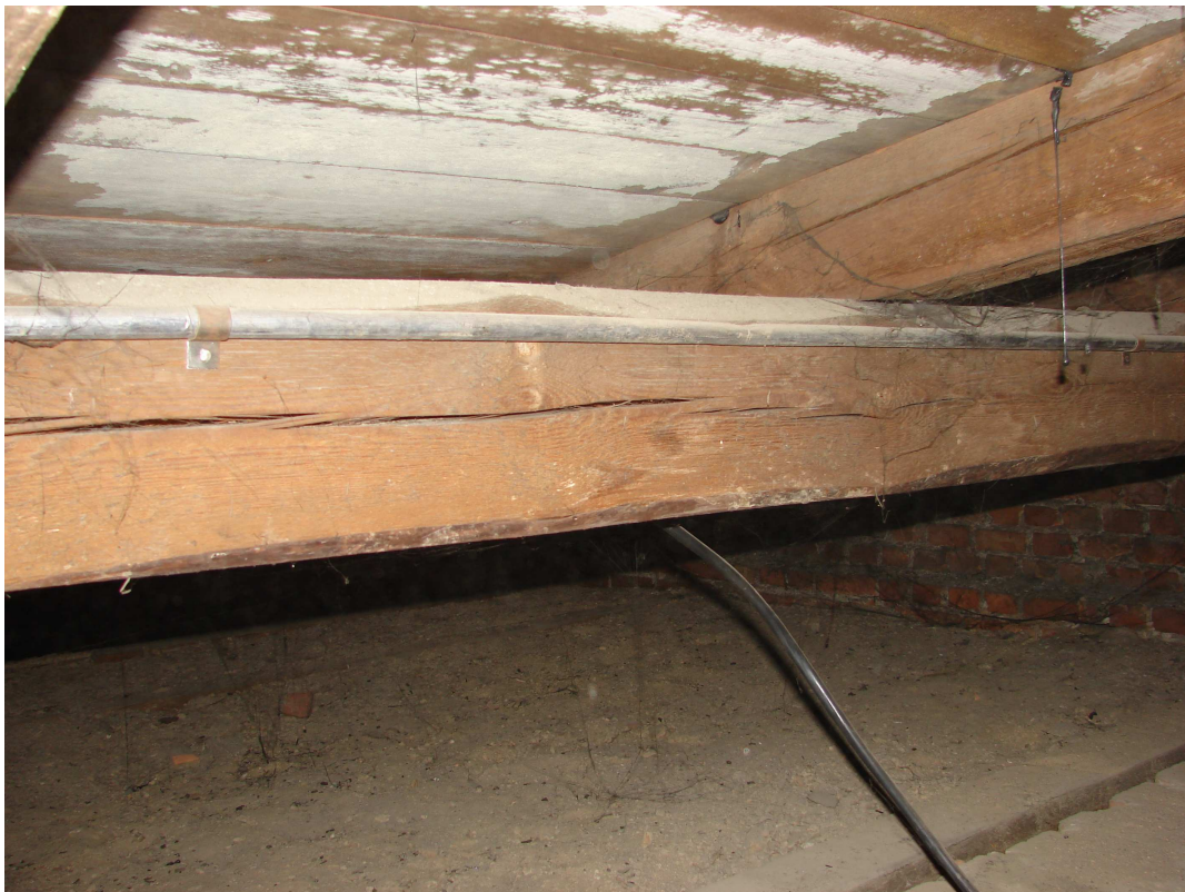
fot. 8 Zawilgocenia poszycia dachu.
