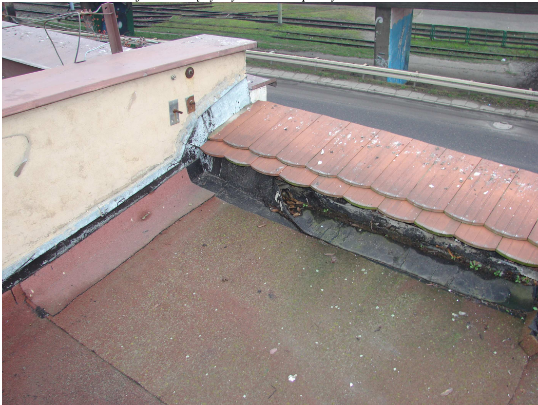
fot. 14 Błędy wykonawcze pokrycia dachu.
