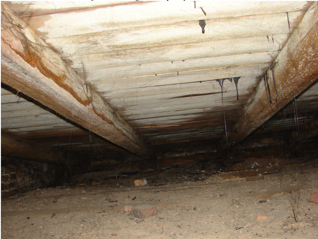
fot. 10 Zawilgocenia poszycia dachu.
