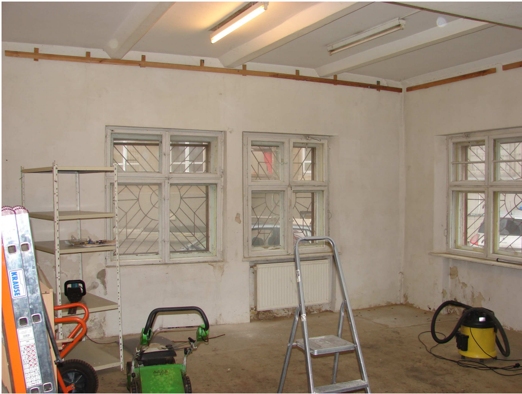
fot. 3 Przebarwienia i odparzenia tynków w ścianie zewnętrznej nośnej.
