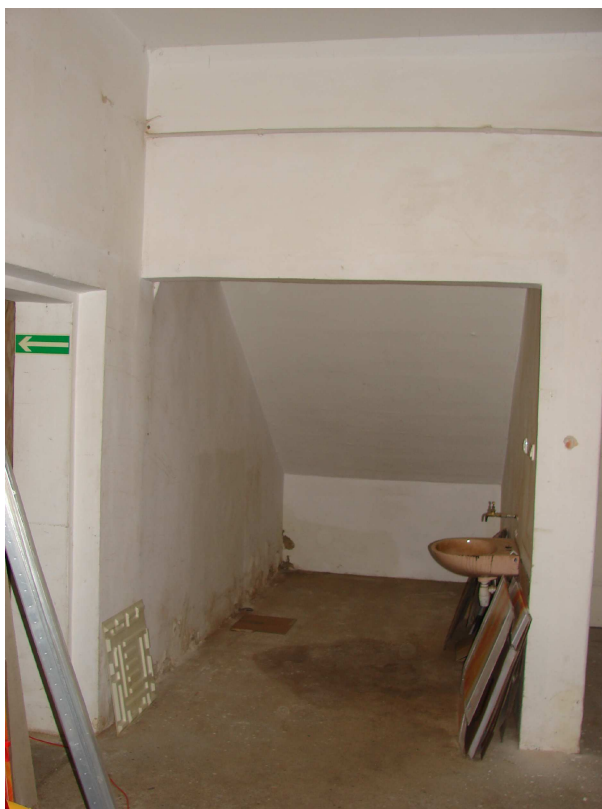
fot. 5 Przebarwienia i odparzenia tynków w ścianie wewnętrznej nośnej.
