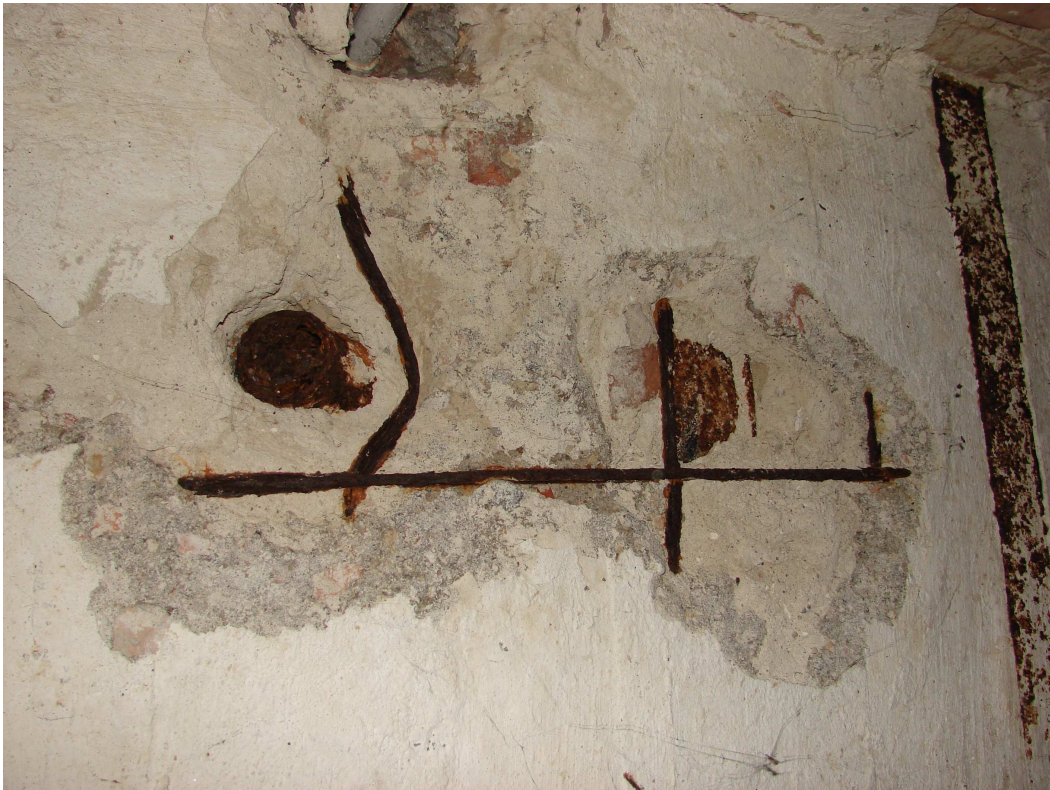
fot. 7 Ubytek w płycie monolitycznej stropu piwnicy.
