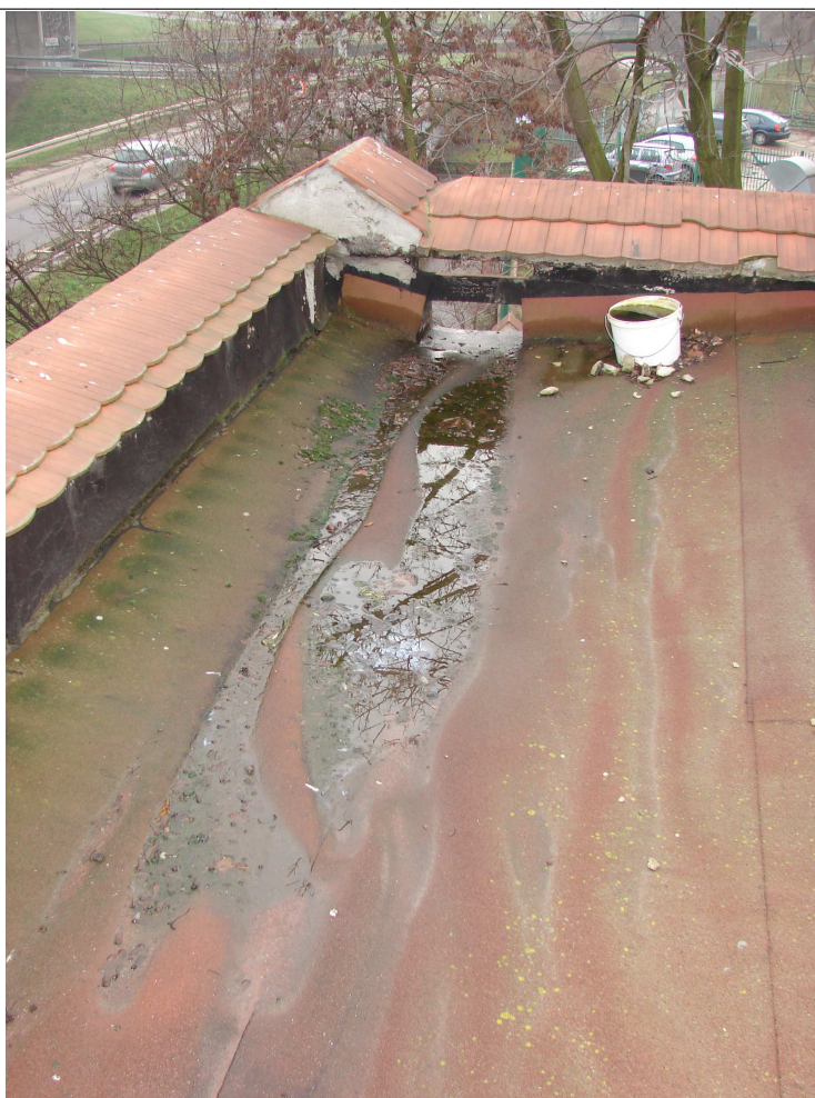
fot. 15 Zastoiny wody na powierzchni dachu.
