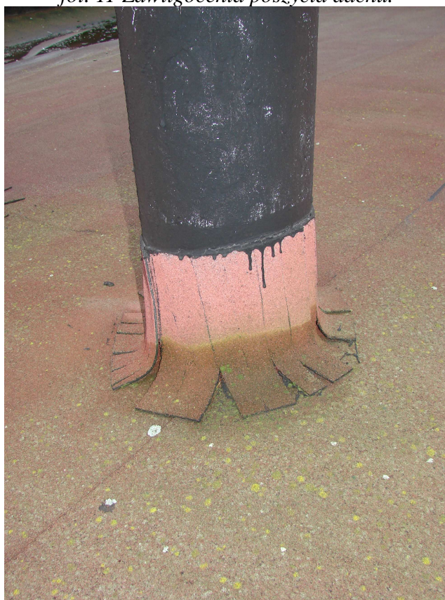
fot. 12 Błędy wykonawcze pokrycia dachu.
