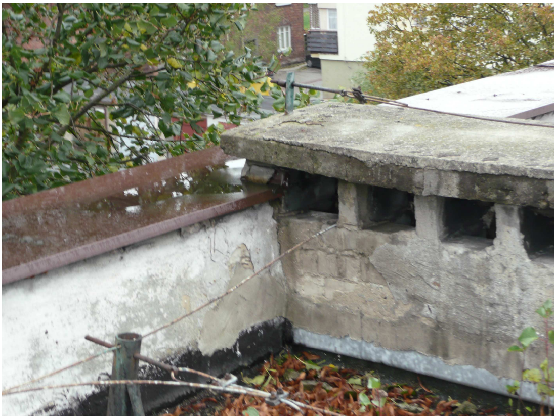
8. Ściana attykowa, kominy, instalacja odgromowa.
