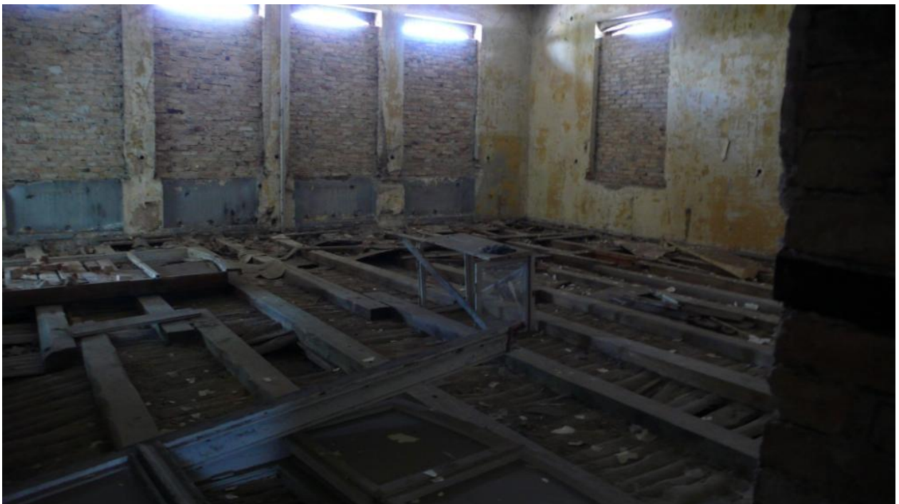
Część nieużytkowana budynku
