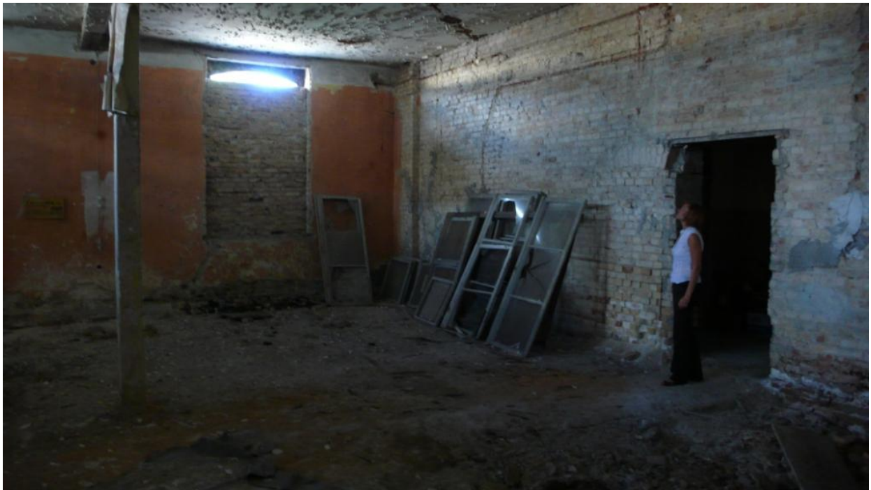
Część nieużytkowana budynku
