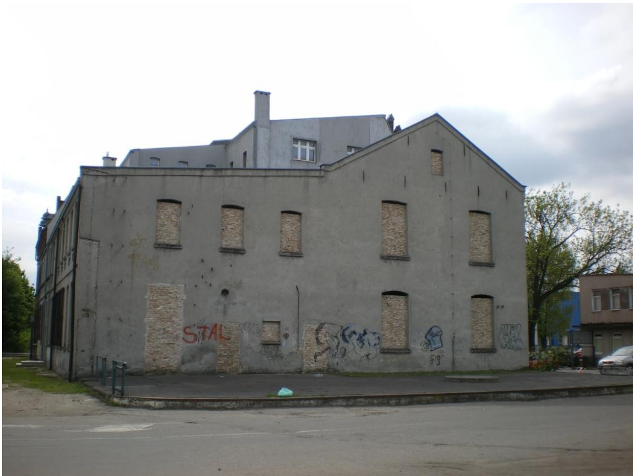
Nieużytkowana część budynku (pod rampą znajdują się zbiorniki ciśnieniowe, poniżej powierzchni)
