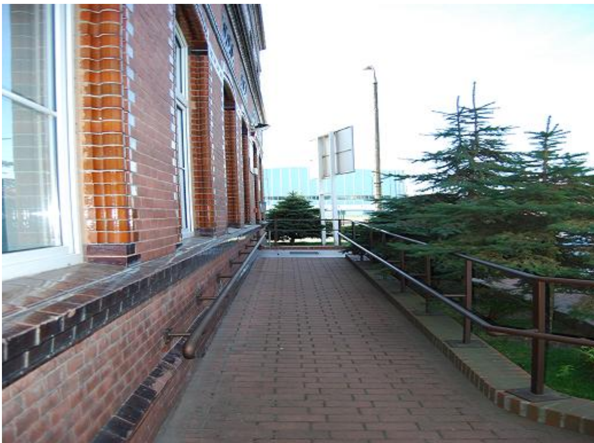
Wejście główne, podjazd dla niepełnosprawnych
